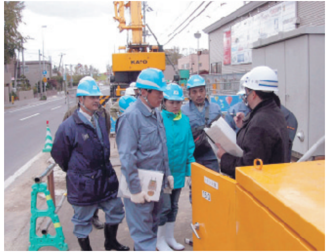
上水道の工事現場で説明を受ける研修員
